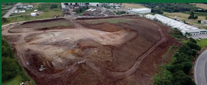
Futuras Instalações - Nova Milano - Farroupilha - RS
