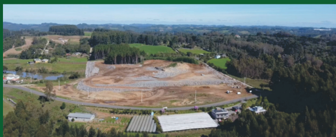
Futuras Instalações - Nova Sardenha - Farroupilha - RS
