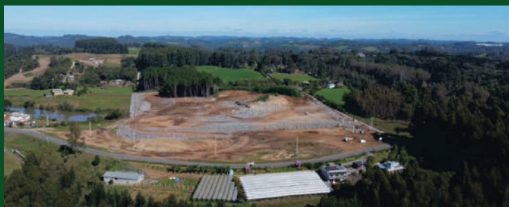
Futuras Instalações - Nova Sardenha - Farroupilha - RS
