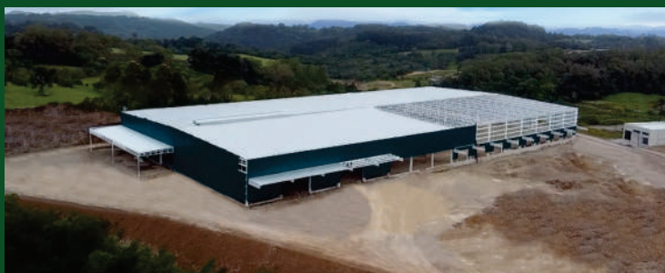
Futuras Instalações - Nova Milano - Farroupilha - RS
