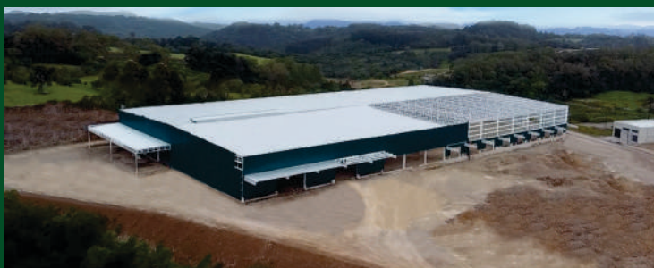
Futuras Instalações - Nova Milano - Farroupilha - RS
