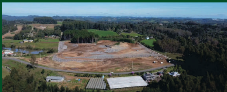
Futuras Instalações - Nova Sardenha - Farroupilha - RS
